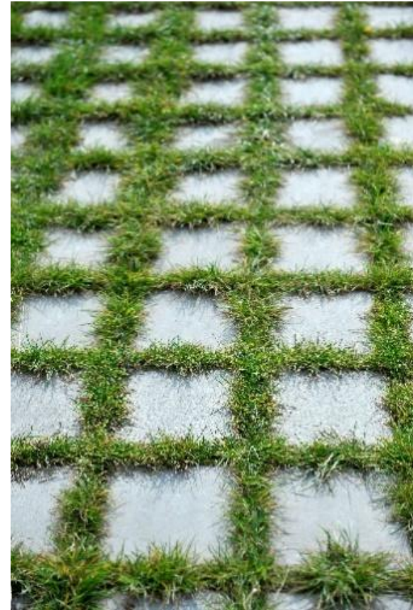
Uitwijkstrook in grasbetontegel
